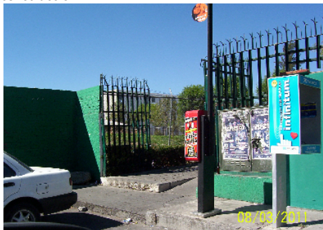
Mejorar el acceso, para evitar se introduzcan personas por la parte baja de la reja, así como mejorar iluminación. Se propone instalar una caseta de vigilancia.
